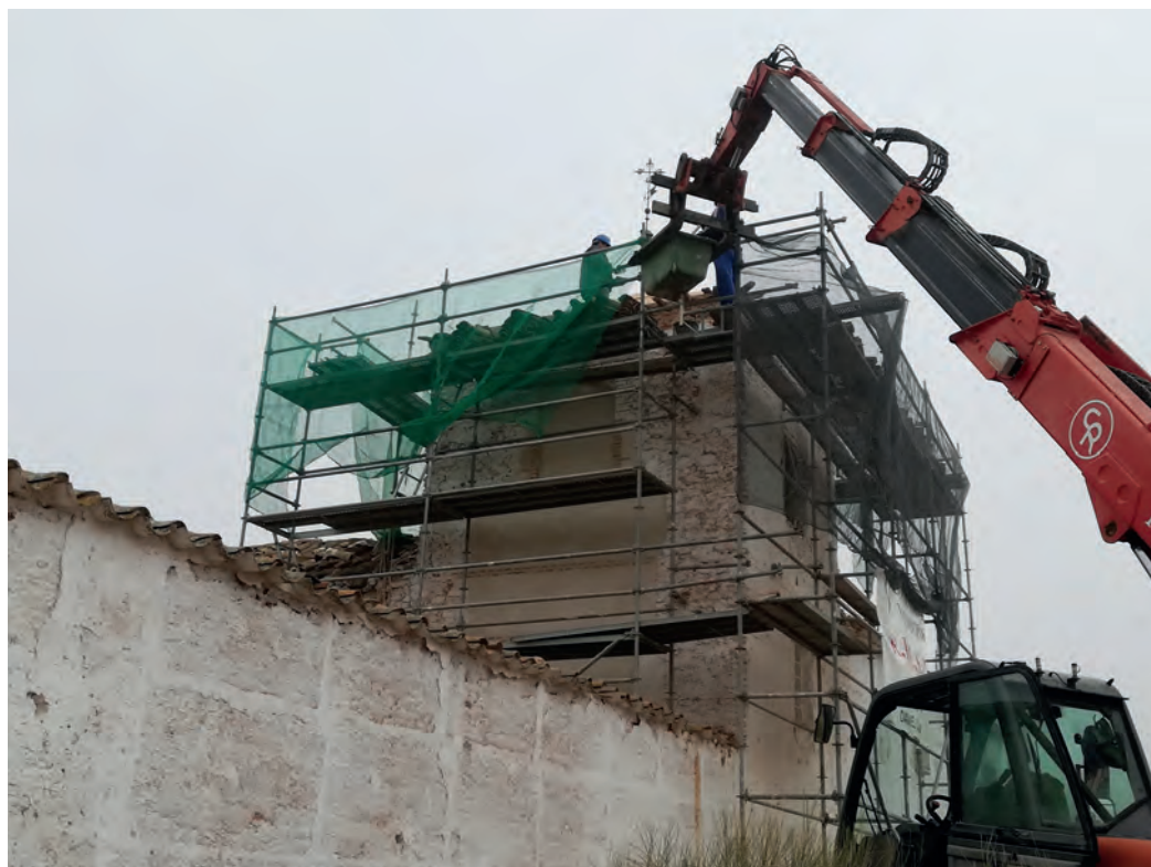
Fig. 3.- Detalle de trabajos en Venta de Borondo. Proyecto 2018.
