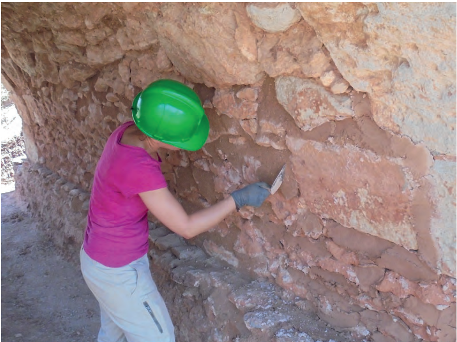
Fig. 2.- Labores de rehabilitación en interior de ojo. Puente Viejo.
