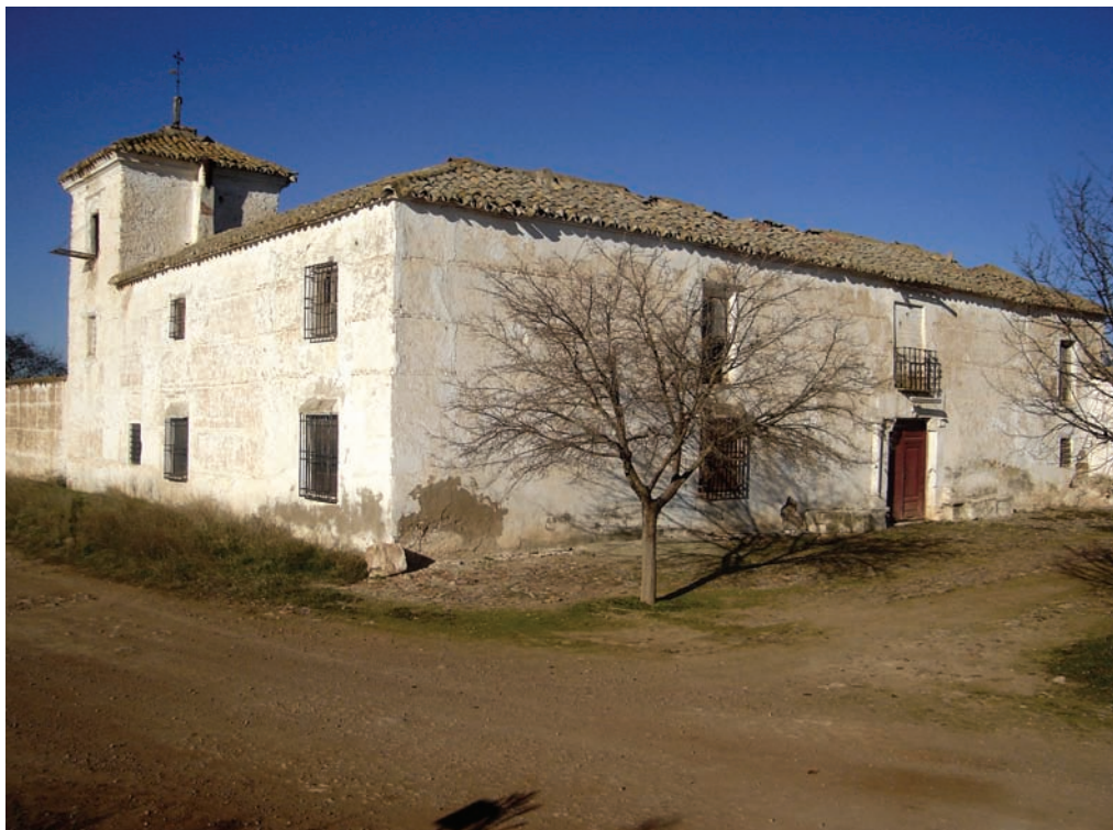
Venta de Borondo. Vista exterior, abril de 2011. Fotografía del autor.
