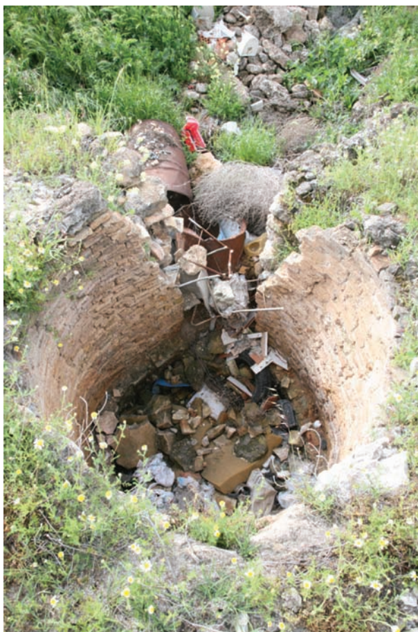
Vista de una calera antes de intervenir.
