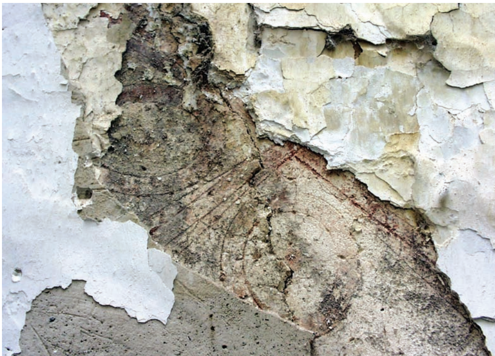
Estado de conservación, donde se pueden apreciar superposiciones de capas ajenas a los motivos pictóricos.
