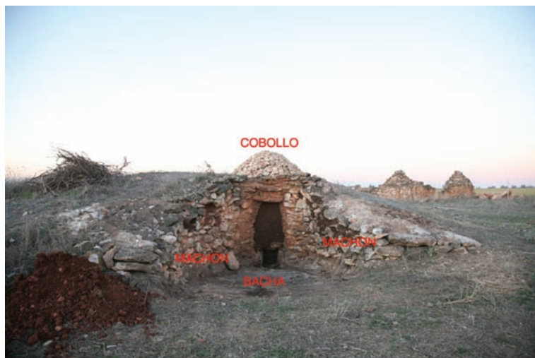
Vista exterior de una calera armada.
