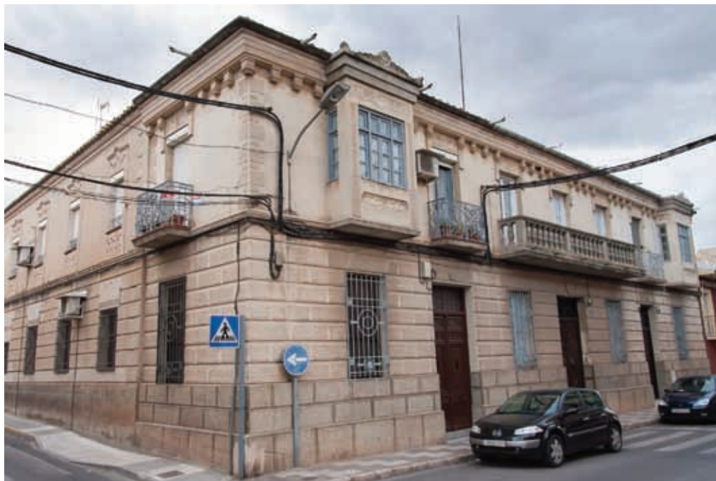
Fig. 6. Casa en calle Estación, 24 a 28
