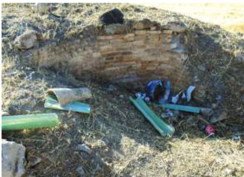
Imagen I. Vista de calera con basuras y residuos.
