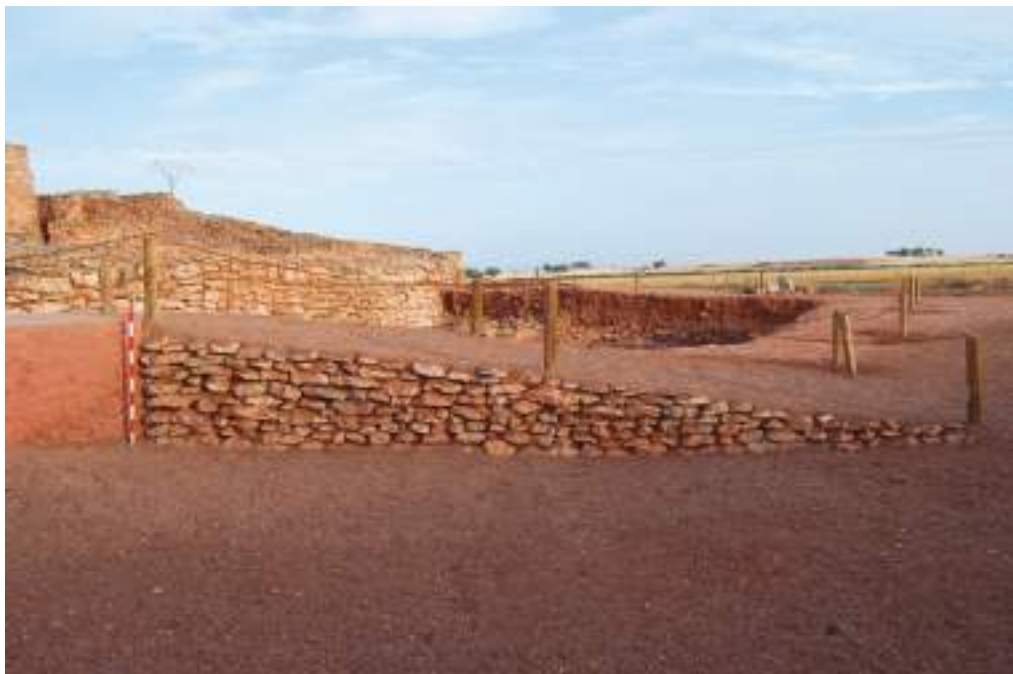
Fig.2. Zona 10, uno de los taludes reforzados con piedra seca.
