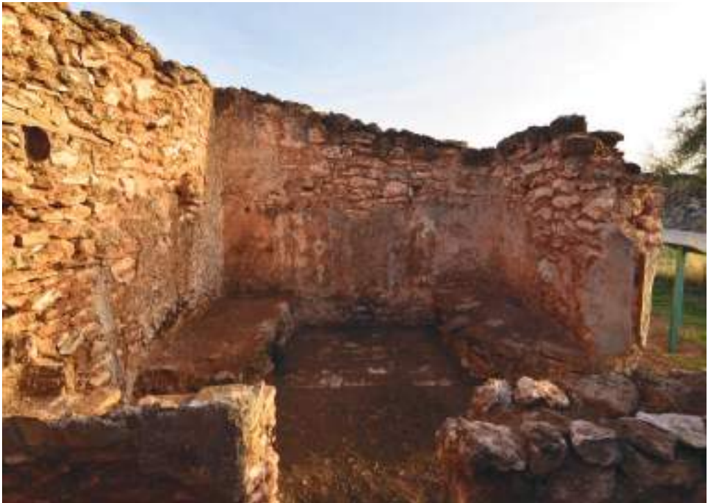
Imagen V. Interior de casilla en calera los Moledores. (Fotografía Julián Bastante)
